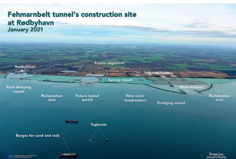
Fehmarnbelttunnel-Baustelle in Rødbyhavn (01/2021)
